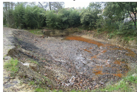
Bassin d'orage existant
