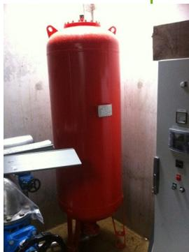
Le projet intègre un ballon anti-bélier de capacité 500 litres dans le poste de surpression, mais également des soupapes et des organes de décharge en plusieurs points ; les lois de fermeture des vannes motorisées aux points de distribution permettent de maîtriser les à-coups hydrauliques.
