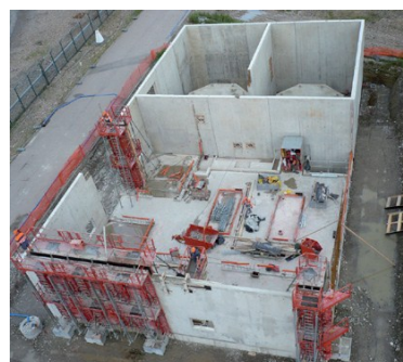
Avancement des travaux
