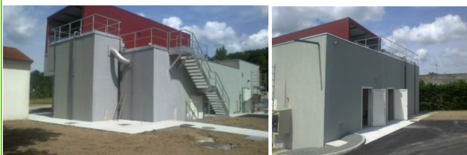
Usine de production d'eau potable du Longeron
