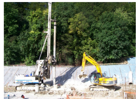
Exécution des fondations : forage des pieux
