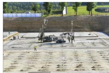
Photo de chantier, réalisation des fondations
